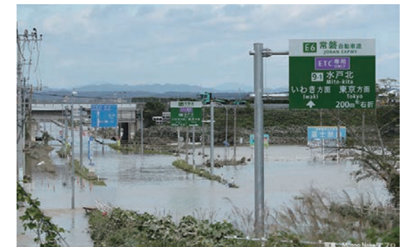
台風19号の豪雨により水没した常磐自動車道
