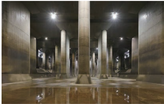
首都圏外郭放水路の調圧水槽内
